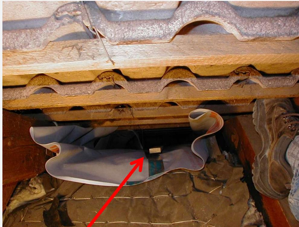
Hilfslatte für **Hinterlüftung**
