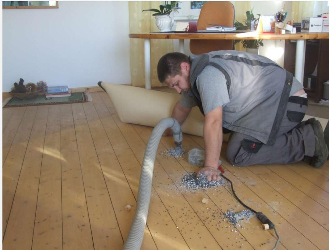
Holzböden auf Balkenlage – von oben dämmen
