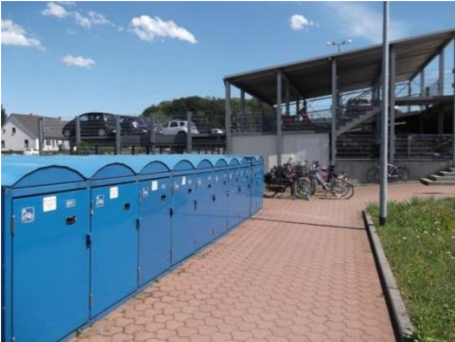
Fahrradabstellanlage mit Fahrradgaragen am Bahnhof Soest Foto: Kreis Soest/ Wolters
