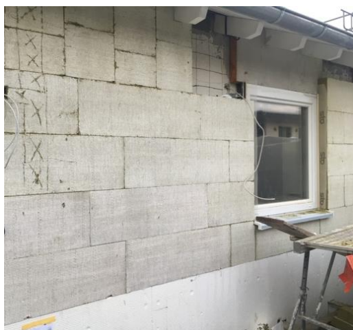
Sanierungsbeispiel: Anbringung eines Wärmedämmverbundsystems (WDVS) an einem Wohnhaus Foto: Kreis Soest/ Hockelmann
