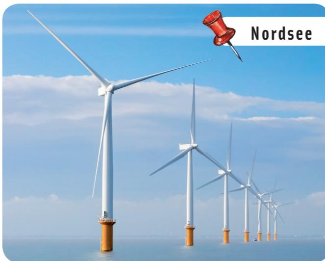
Knapp 160 Meter ragen die Windräder in den Himmel. In der Nordsee, nicht weit von der Insel Helgoland entfernt, drehen sich riesige Rotorblätter mit einem Durchmesser von 126 Metern, nehmen die Energie des Windes auf und erzeugen so klimafreundlichen Strom. Beim Offshore-Windkraftwerk erzeugt jede Windturbine den Strom für umgerechnet 6.000 Haushalte. ★rh
