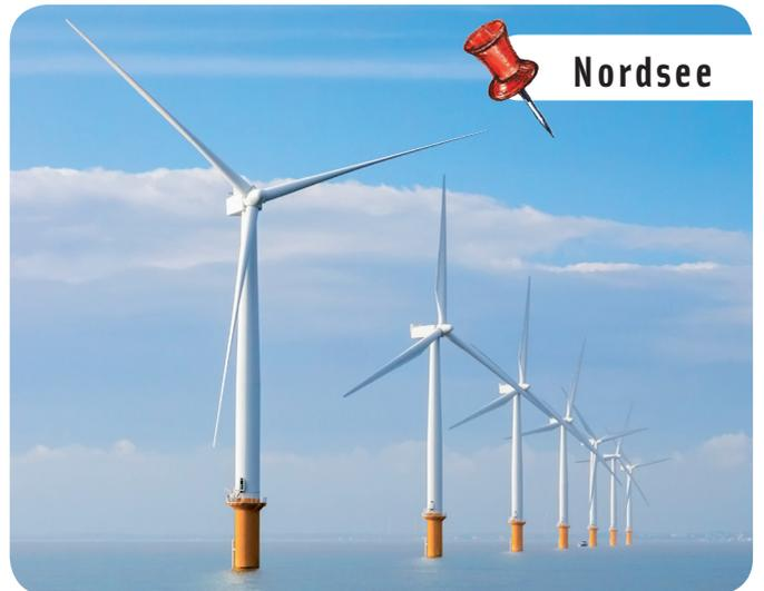
Knapp 160 Meter ragen die Windräder in den Himmel. In der Nordsee, nicht weit von der Insel Helgoland entfernt, drehen sich riesige Rotorblätter mit einem Durchmesser von 126 Metern, nehmen die Energie des Windes auf und erzeugen so klimafreundlichen Strom. Beim Offshore-Windkraftwerk erzeugt jede Windturbine den Strom für umgerechnet 6.000 Haushalte. ★rh
